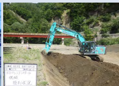
自動操縦機能搭載の建機
