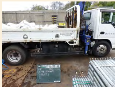
トラックに積み込んで運搬します
