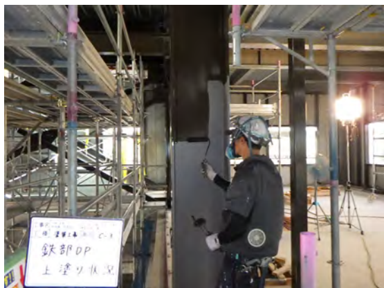
保護具を着用しながら塗装作業
