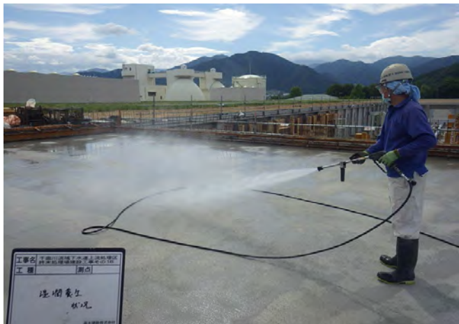
中水を利用した生コン打設後の水養生
