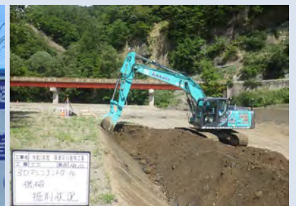
自動操縦機能搭載の建機
