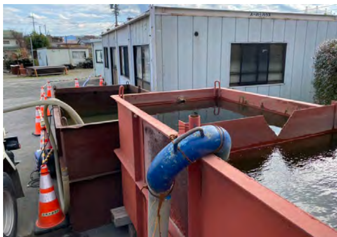
作業所にて、貯めた雨水を汲み上げている
