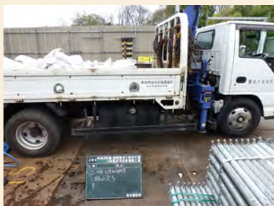
トラックに積み込んで運搬します
