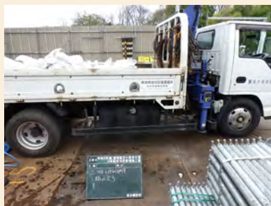
トラックに積み込んで運搬します
