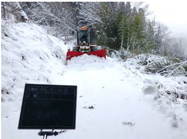
除雪の様子。深夜でも要請があれば現場へ赴き、作業を行ないます。
