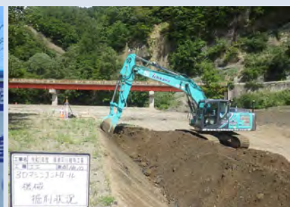
自動操縦機能搭載の建機
