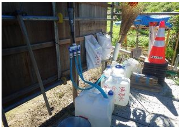
※ 現場における雨水の利用
