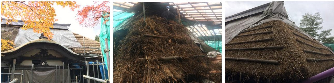
※ 神原家主屋修理工事
