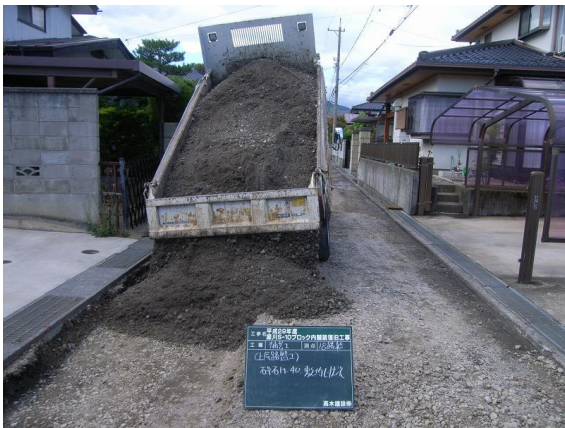
※ Rアスコンの使用状況
