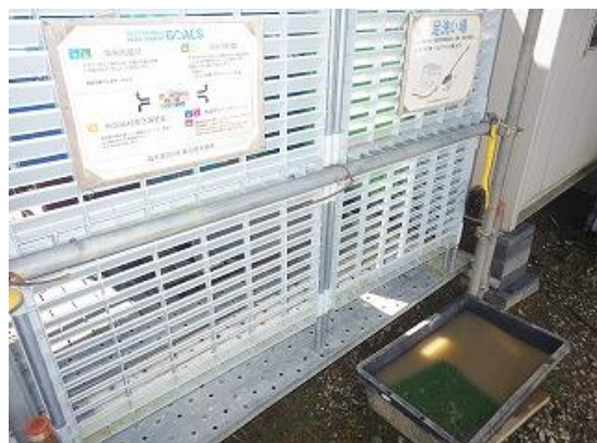
※ 雨水の利用による靴の泥落としに活用
