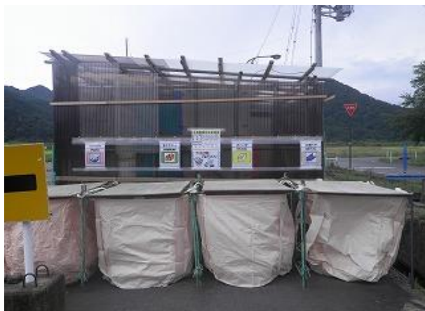
※ 作業所における産業廃棄物分別状況、社内安全パトロールにて分別状況を確認している
