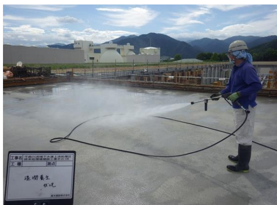
※ 中水を利用した生コン打設後の水養生
