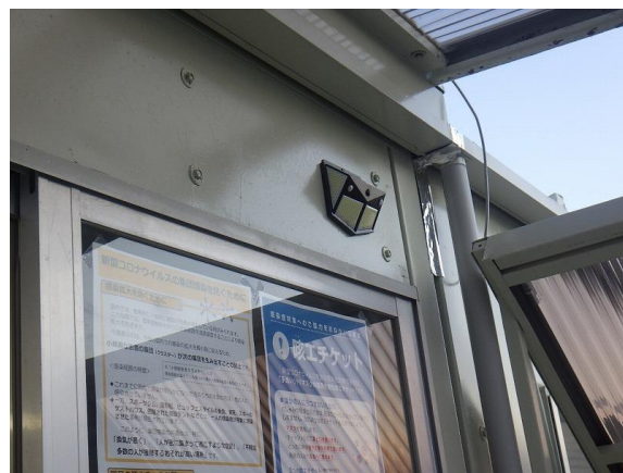
※ 現場事務所にてソーラー電気を利用
