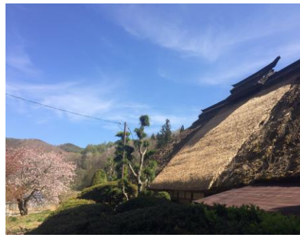
※ 青木家茅葺き屋根修理工事
