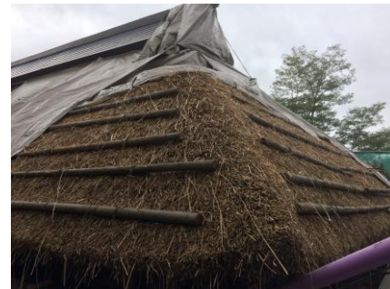
※ 神原家主屋修理工事
