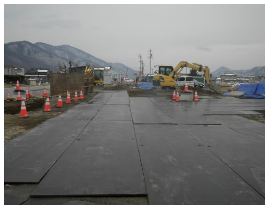
※ 敷鉄板を行なうことで道路への土のまき出しを防止し、節水に努めている
