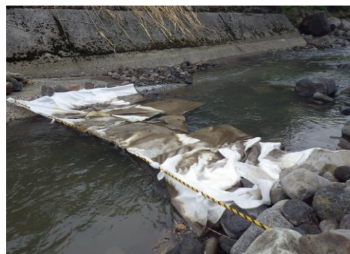
※ 緊急事態対応訓練（オイルマットの使用）
