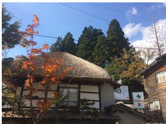
茅葺き屋根葺き替え工事（戸隠 武田旅館様）
