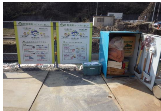
※ 作業所における油流出時対策キットの設置
